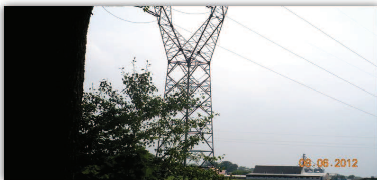
Linia energetyczna na terenie lokalizacji Farmy Wiatrowej Jeżewo
