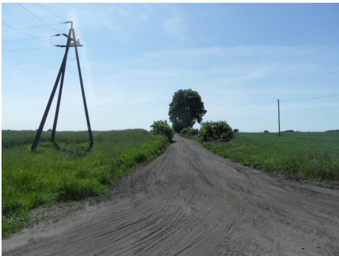
Rysunek 2. Droga obok terenu planowanego przedsięwzięcia – widok od strony Buczka w kierunku Krąplewic
