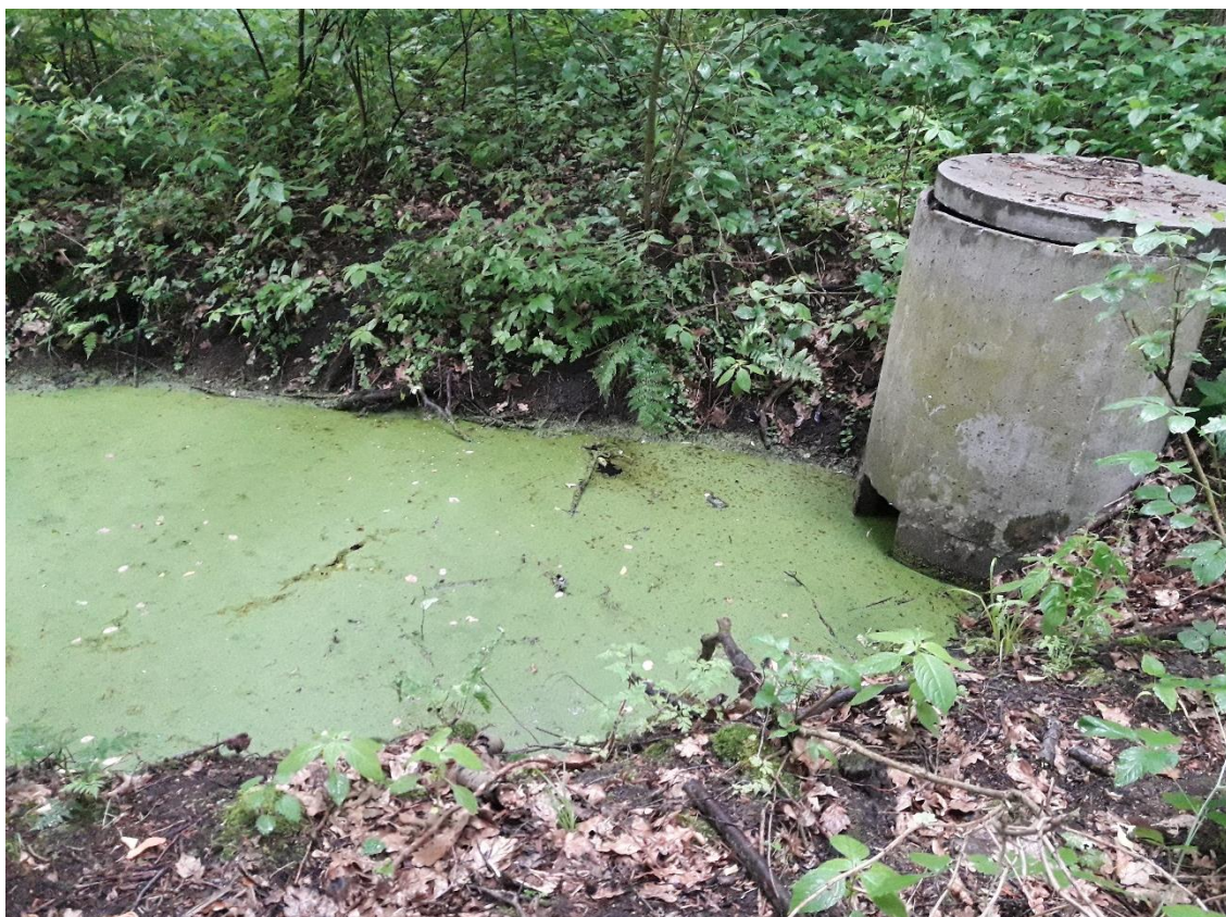
Rysunek 24. Rów melioracyjny ze studzienką odprowadzający wody z działek, oczek inwestora do rzeki Wdy przy drodze przed skrzyżowaniem Laskowice-Osie
